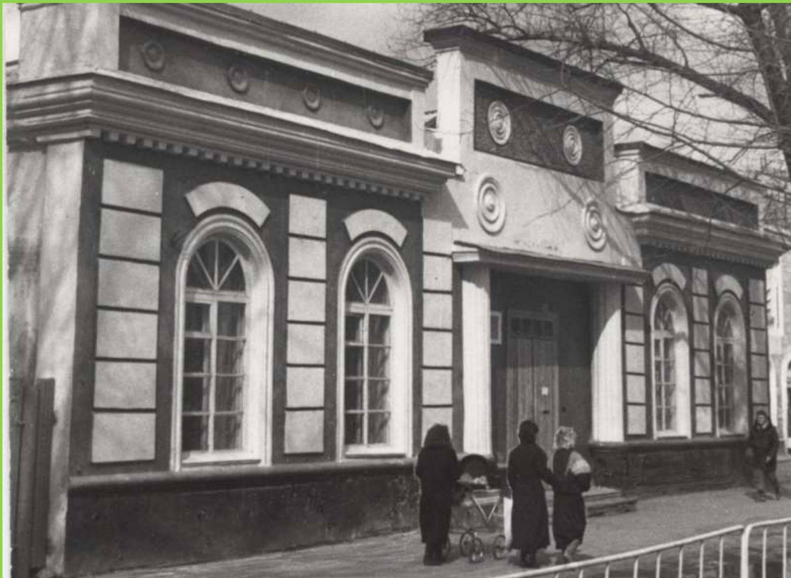
г. Кореновск, ул. Красная. Здание ДШИ (детской школы искусств) № 1.
